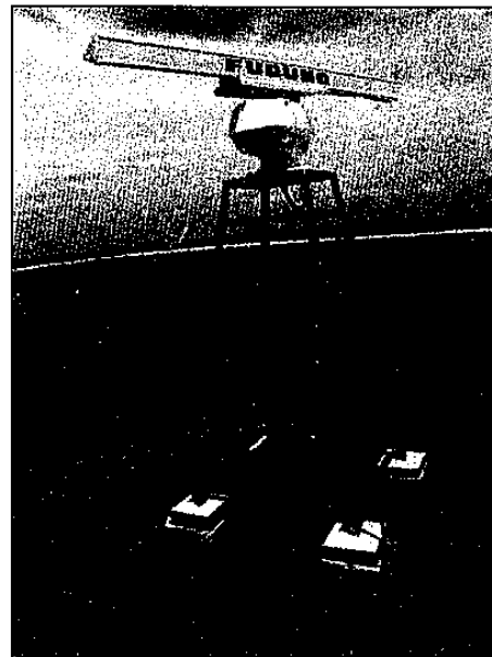
圖四、雷達天線安裝完成照片
